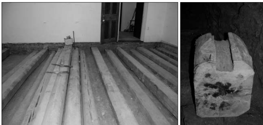
Středový trám v mezistropu nad „erbovní místností“, detail
