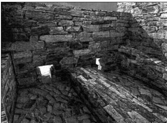
Rekonstrukce vnitřního řešení vápenické pece
