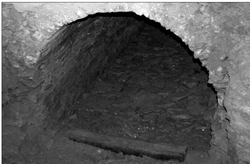
Prahový trám ve vstupu do sklepa
